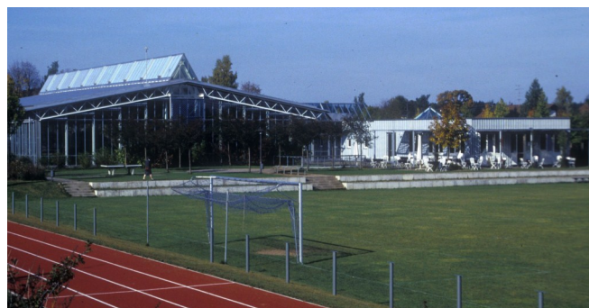
Die Mehrzweckhalle mit Sulag und Sportanlagen
